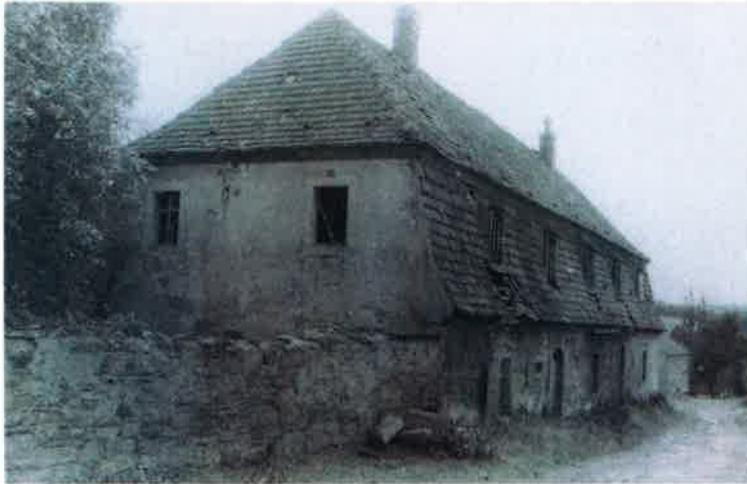
Abbildung 10: Ansicht der Orangerie von Nordosten. Die Gartenmauer reicht bis an die Orangerie heran. Die Mauerkrone ist größtenteils nicht mehr vorhanden. Direkt an der Orangerie befinden sich Steinplatten auf der Mauerkrone mit Gefälle zur Straße. Foto von 1963.
