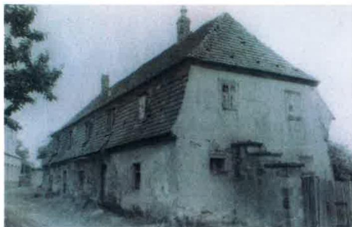
Abbildung 12: Ansicht der Orangerie von Nordwesten. An den Giebel der Orangerie stößt ein abgestuftes Mauerstück an. Dabei handelt es sich vermutlich um eine Toreinfahrt. Das Mauerstück ist verputzt, die Ecke besteht aus Sandsteinquadern. Die Mauer ist mit Sandsteinplatten abgedeckt, augenscheinlich in Sattelform. Foto von 1963
