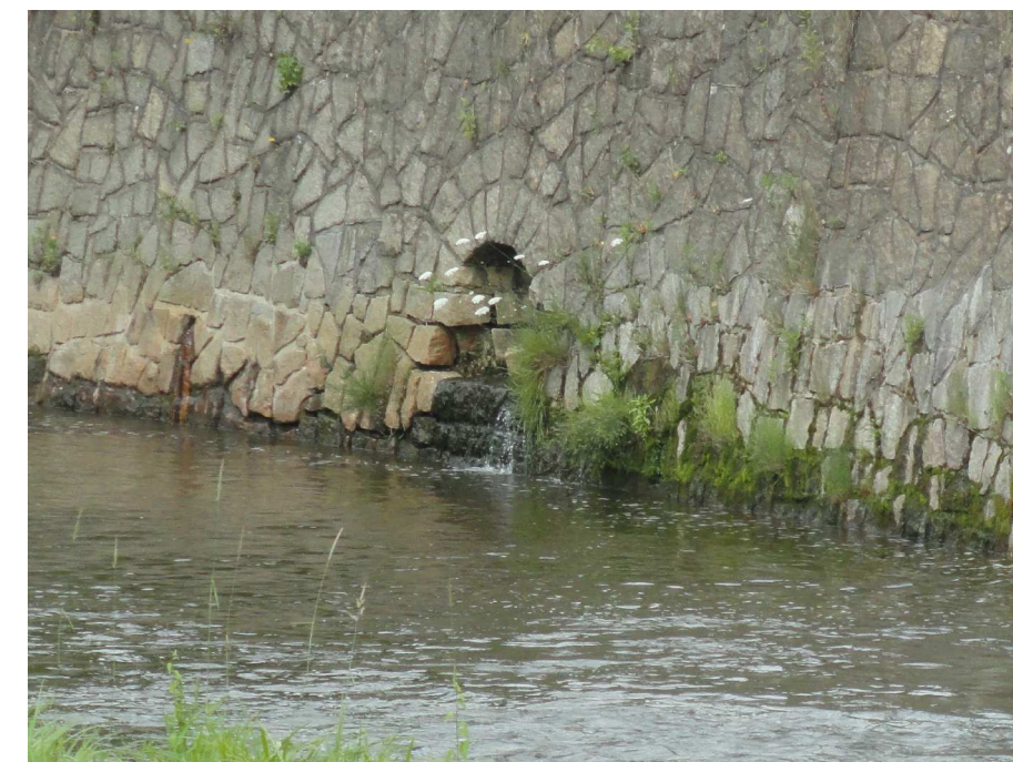
Bild 3 - Ufermauer der Müglitz - Einbindung der Verrohrung
