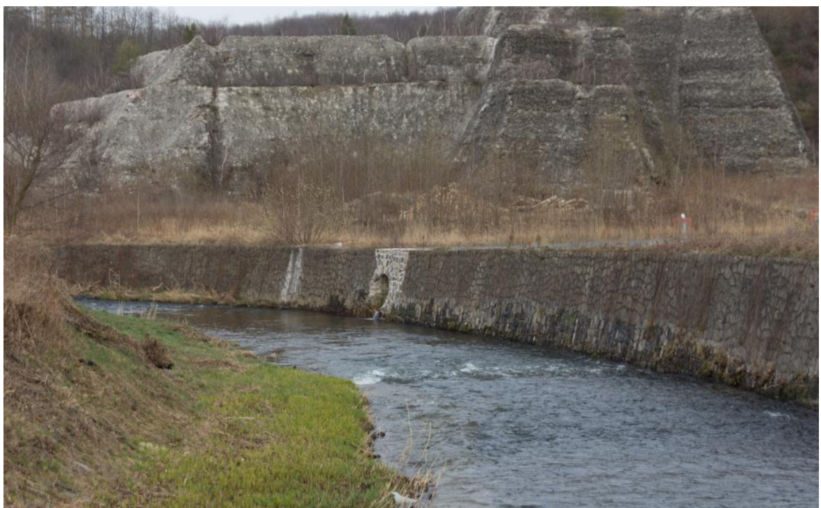
Abbildung 19 Ansicht Müglitzmauer mit neuem Auslauf Bodlitz-Kanal
