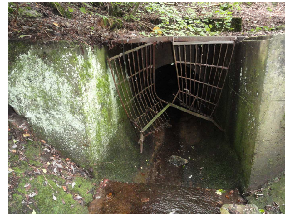
Bild 1 - Einlaufbauwerk mit Rechen
