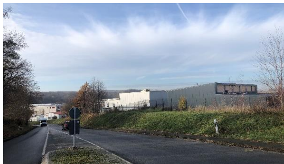
Gewerbegebiet Reppchenstraße rechts der Straße Am Kuxberg
